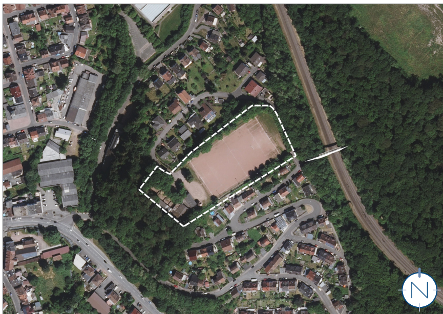
Luftbild mit Geltungsbereich, o.M.; Quelle: Geobasisinformationen der Vermessungs- und Katasterverwaltung, Aktualität der Geobasisinformationen: 09.09.2025; Bearbeitung: Kernplan
